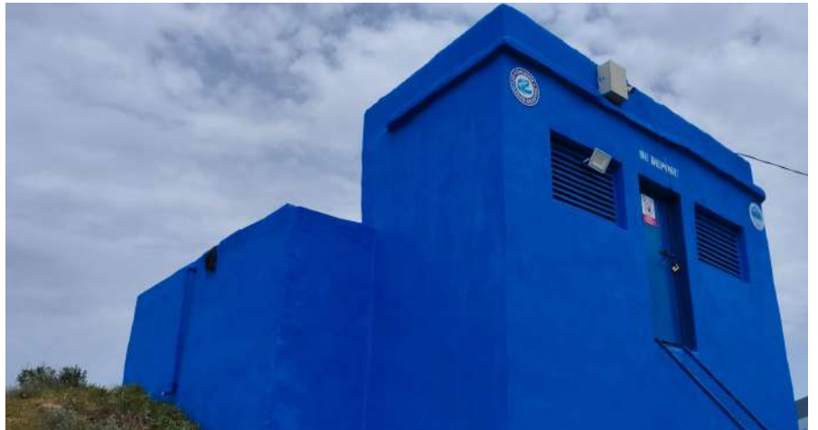
Mahmudiye Su Deposu Bakım ve Onarım Sonrası
