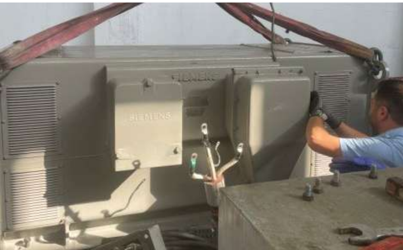
Temizsu Pompa İstasyonu
