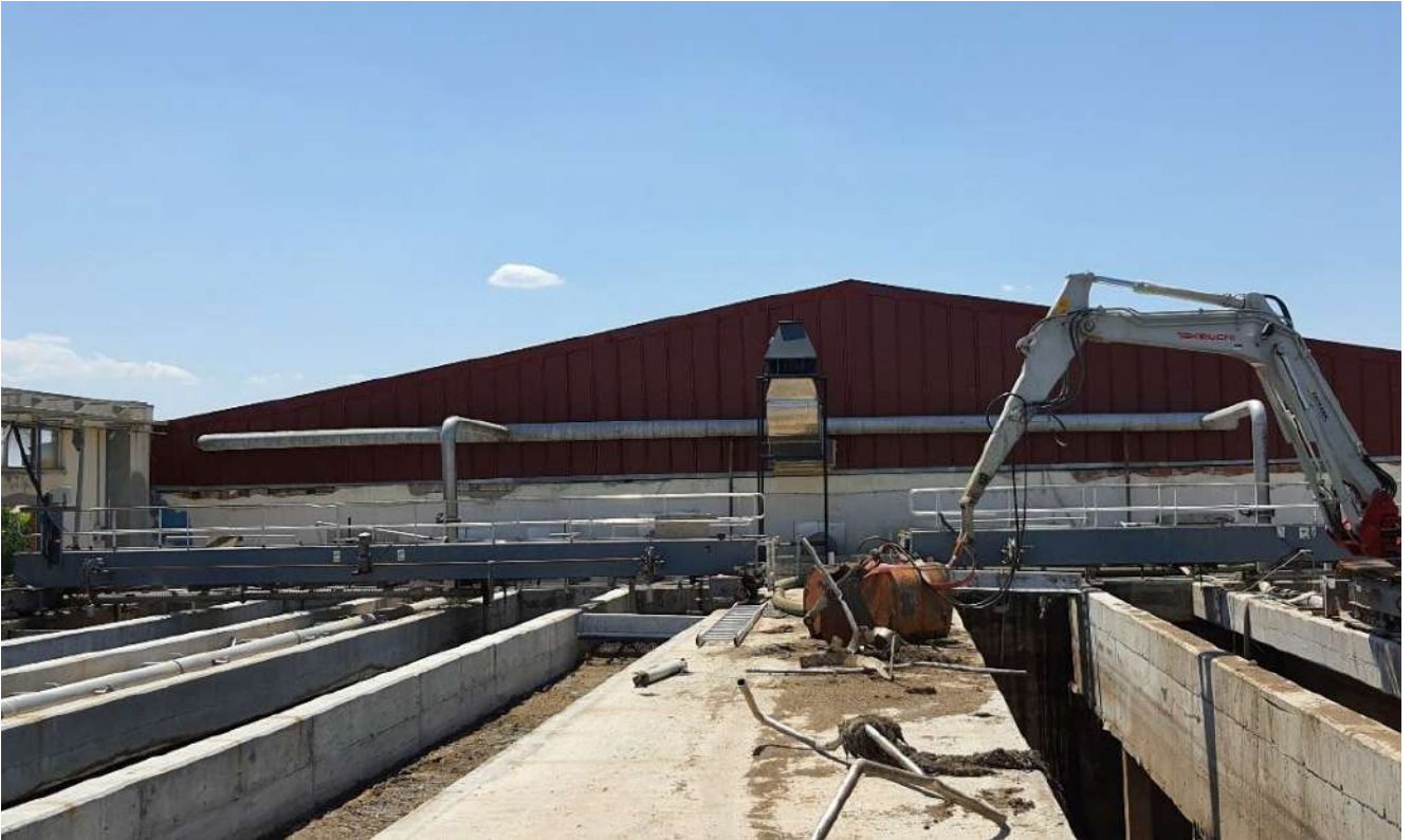
Ayaklı Betonarme Su Deposu Yıkım İşi
