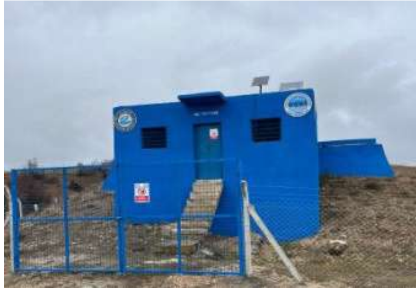
Mahalle Su Deposu
