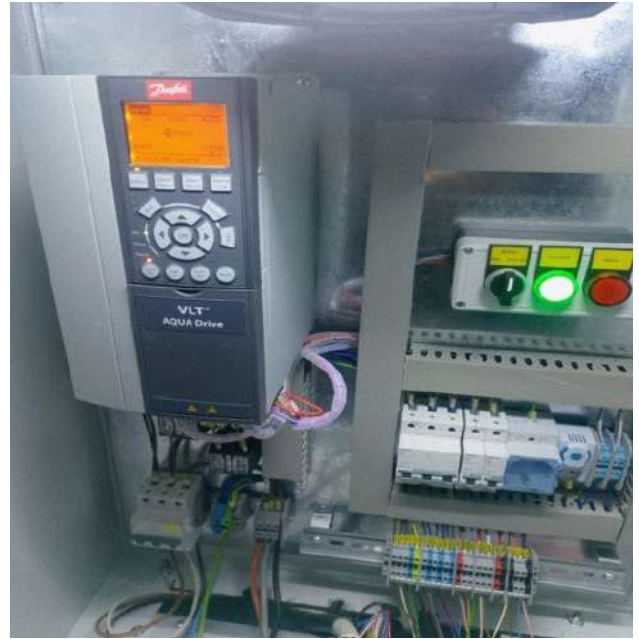
Frekans Konvertörü Montaj İşİ
