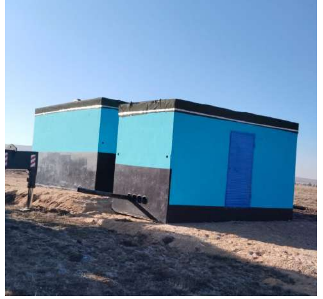
İçme ve Kullanma Suyu Deposu ve Vana Odası Montaj İşİ
