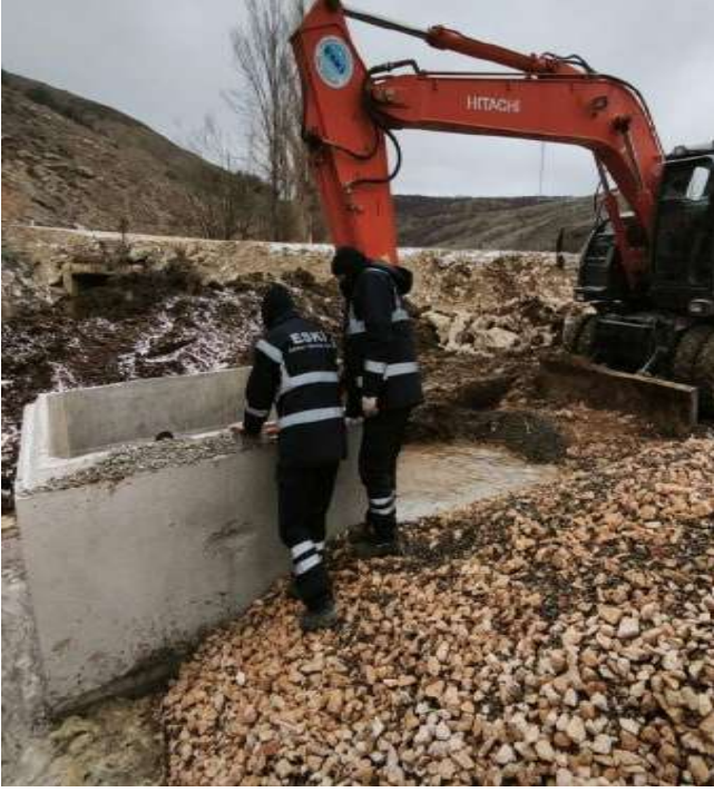
İçme ve Kullanma Suyu Kaptaj Yapım İşi
