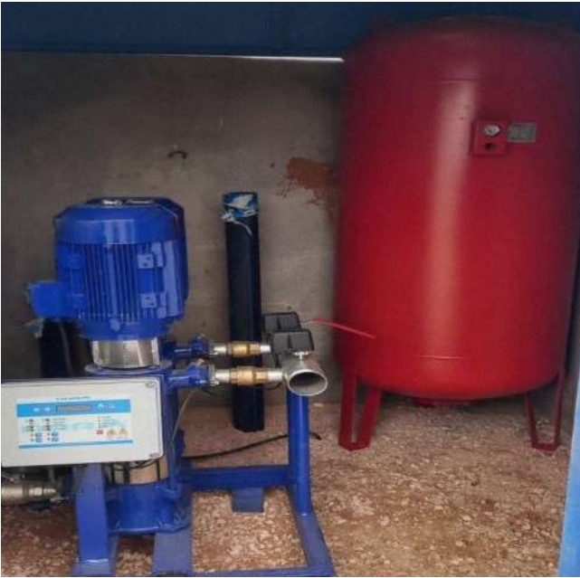
Hidrofor Sistemi Montajı
