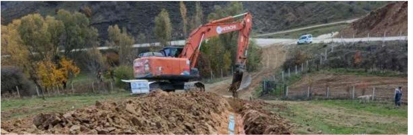
Şebeke Hattı Yapım Çalışması
