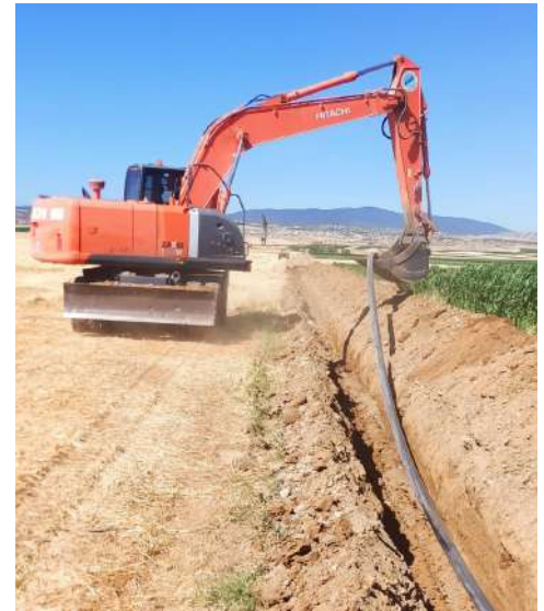
İçme ve Kullanma Suyu Hattı Yapım İşİ
