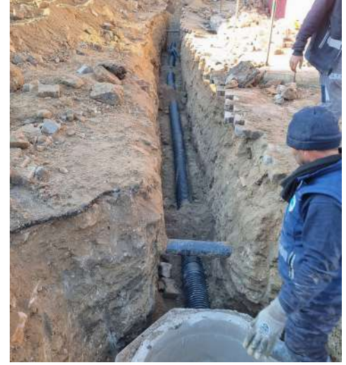
Kanalizasyon Hattı Yapım İşi
