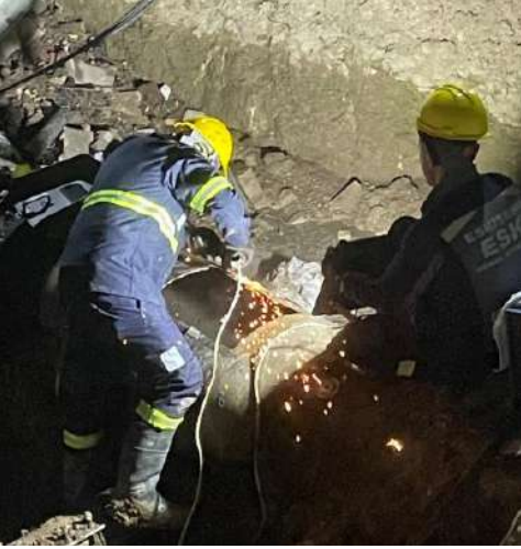
Gömece Lojmanları İçme Suyu Hattı
