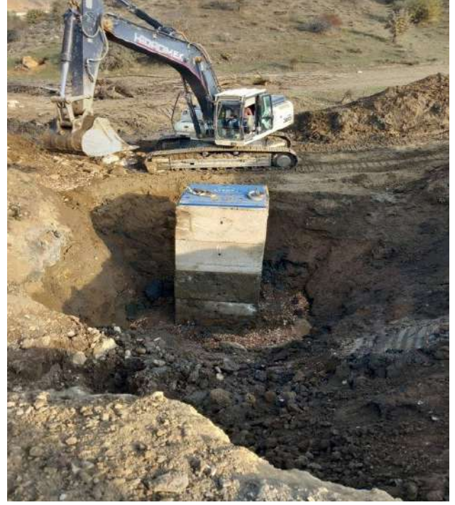
İçme ve Kullanma Suyu Kaptaj Yapım İşi
