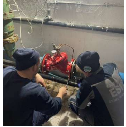
Servis Suyu Hattı
