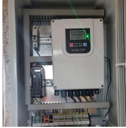
Erken Uyarı ve Otomasyon (SCADA) Sistemi Montajı
