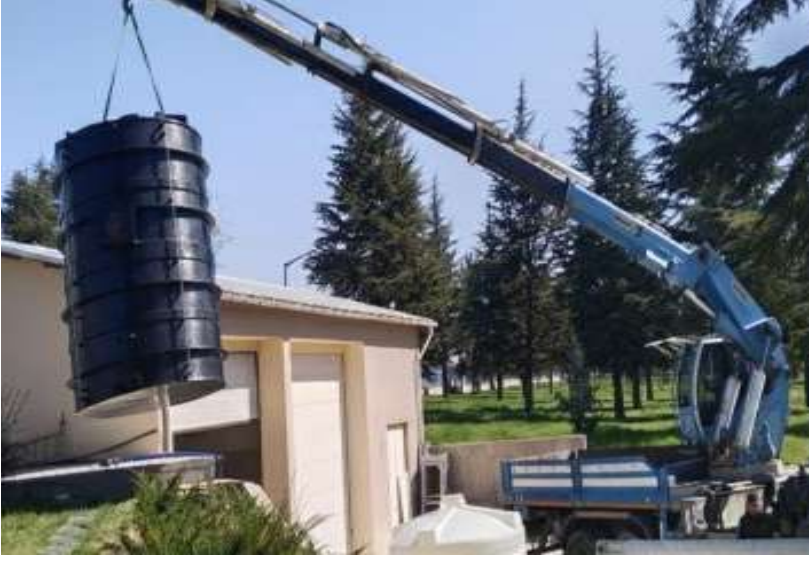
Sıvı Klor Deposu
