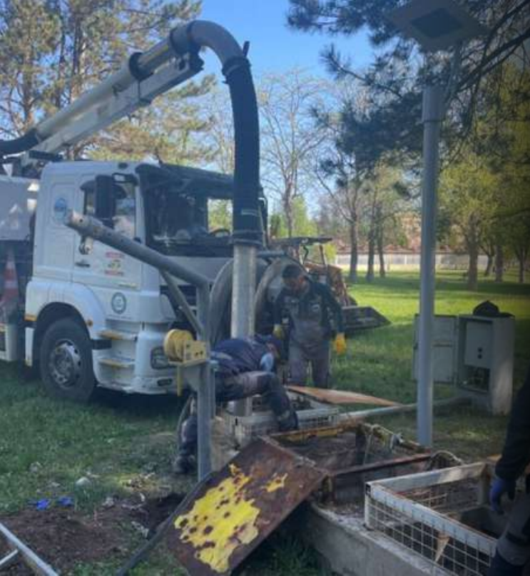
Kampüs Atıksu Terfi Temizliği
