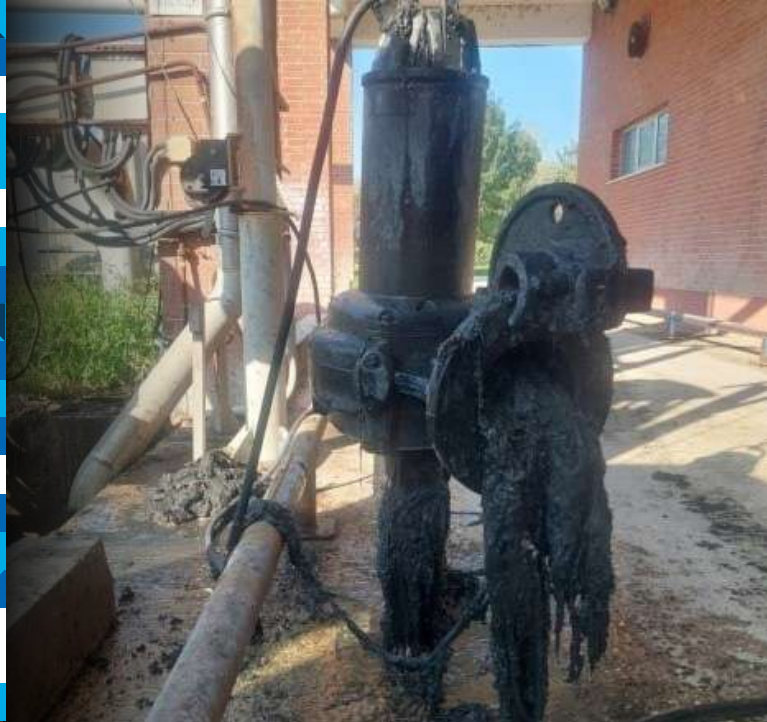
Süzöntü Suyu Pompası Bakımı
