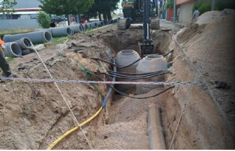
Yağmur Suyu Hattı Yapımı
