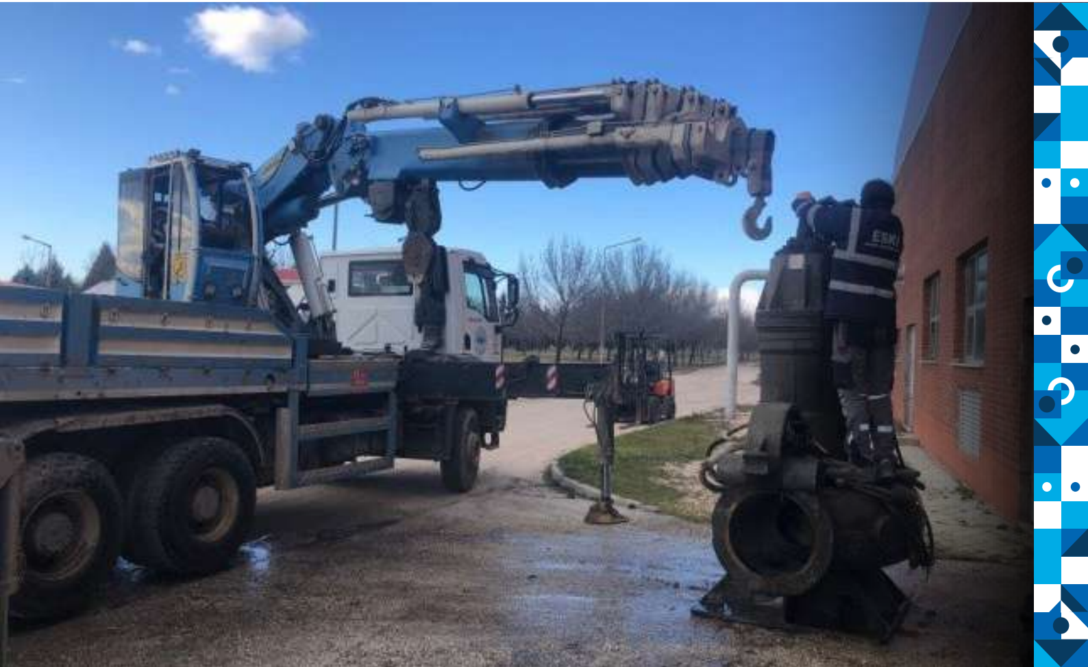
Giriş Pompalarının Periyodik Bakım Çalışması
