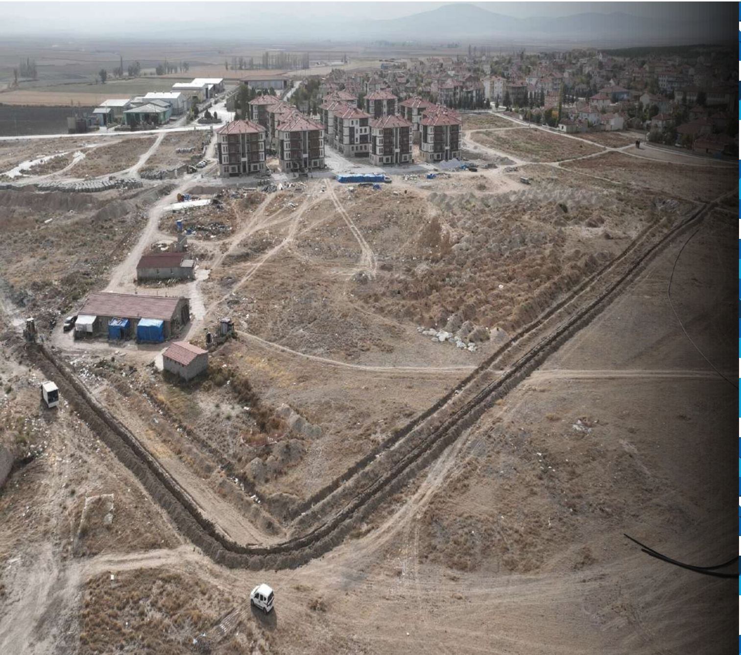
İçme ve Kullanma Suyu Hattı Yapım İşİ
