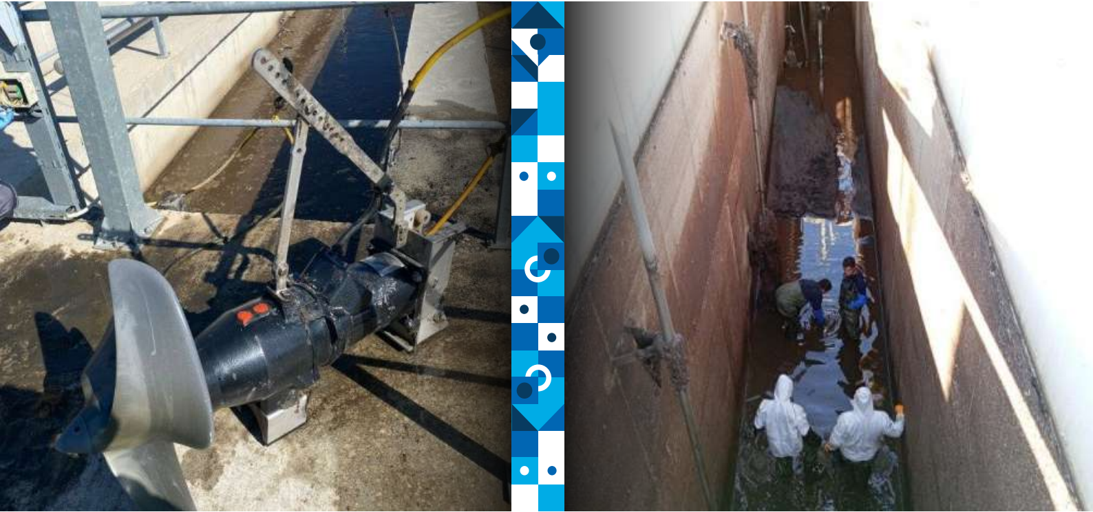
Difüzör ve Mikser Bakımı
