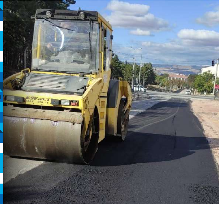
Altyapı Çalışmalarının Asfalt Yama İşi
