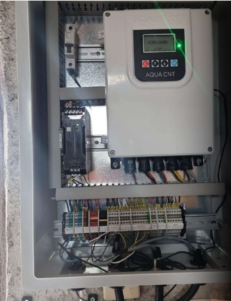
Erken Uyarı ve Otomasyon (SCADA) Sistemi Montajı
