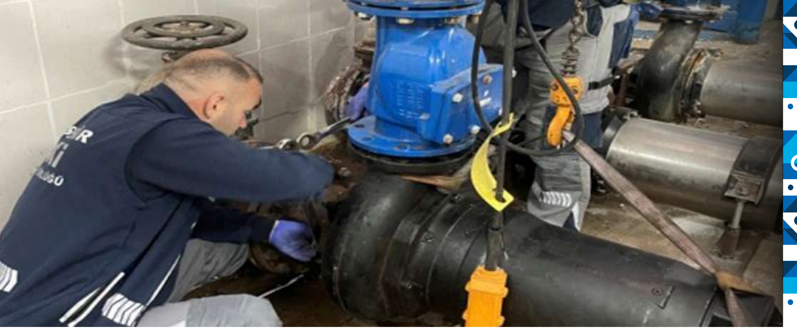
Sazova Atıksu Terfisi Pompa Bakımı ve Arıza Giderimi
