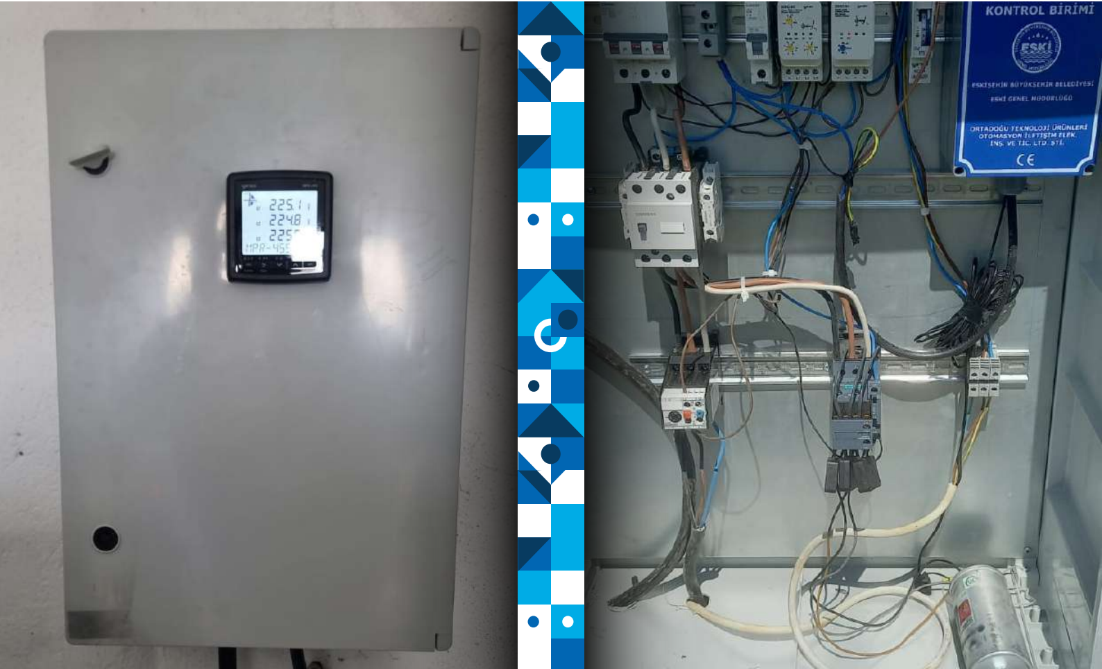
Erken Uyarı ve Otomasyon (SCADA) Sistemi Montajı
