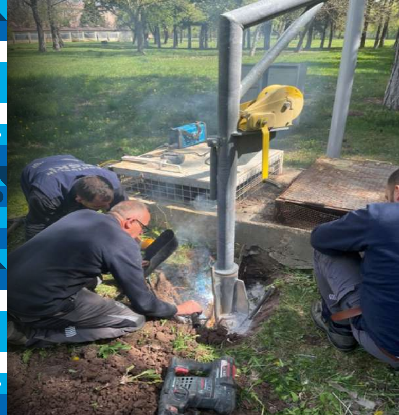
Kampüs Atıksu Pergel Vinç Montajı
