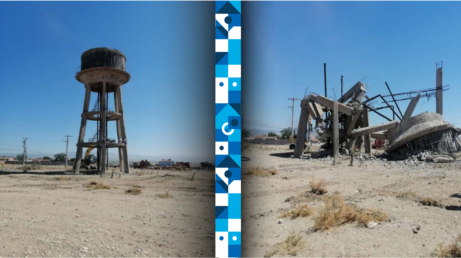
Ayaklı Betonarme Su Deposu Yıkım İşi
