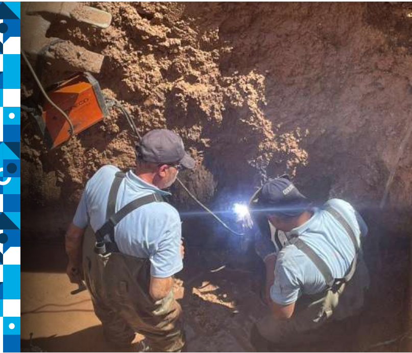
D1 Temizsu Hattı Kaçağı Giderilmesi
