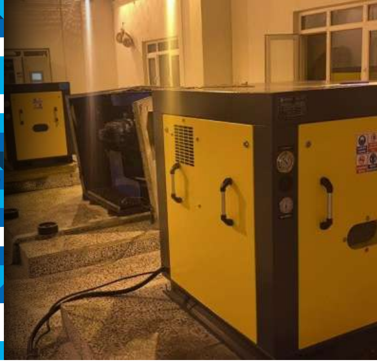
Bakım Yapılan Blower
