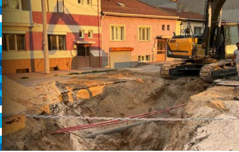
Yağmur Suyu Hattı Yapımı
