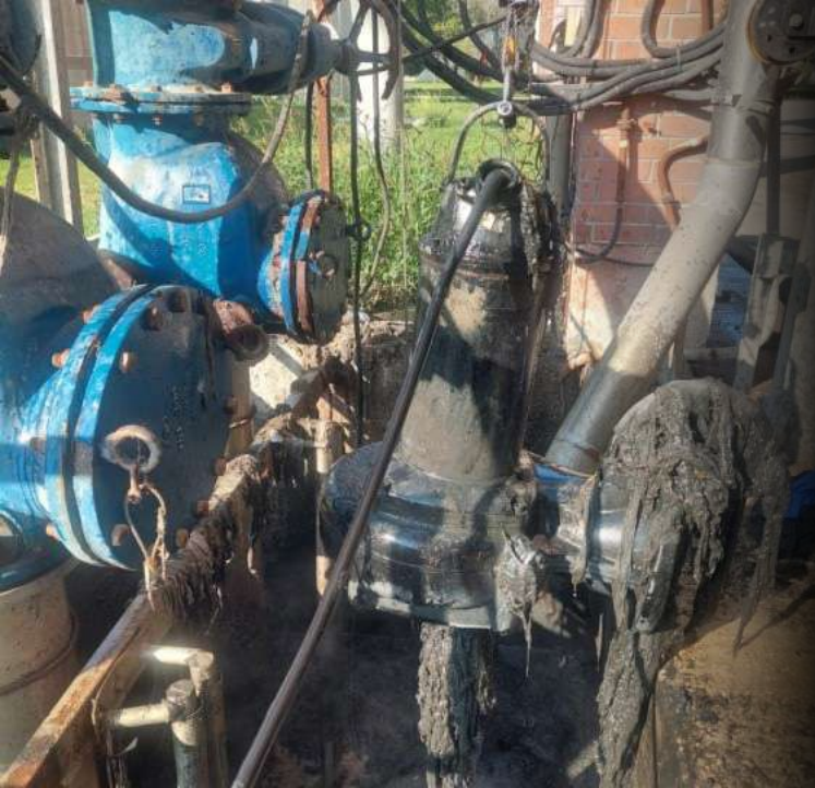
Süzöntü Suyu Pompası Bakımı
