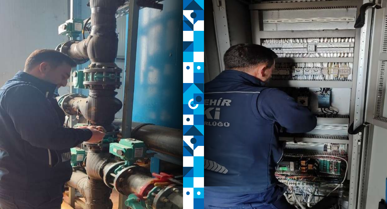
Çifteler Arsenik Arıtma Tesisi Ünite Montajı
