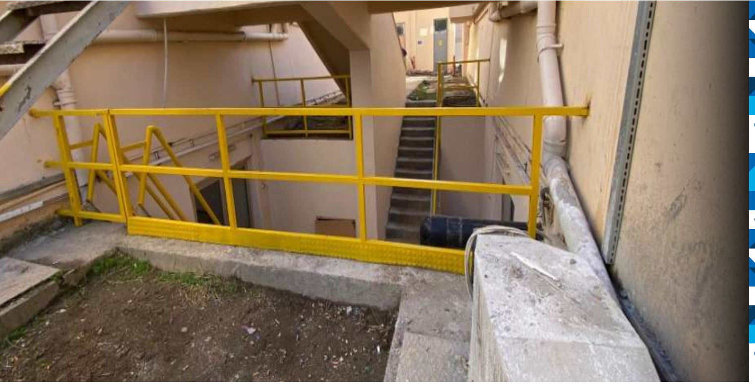
Durultucu Binası Korkuluk Yapımı
