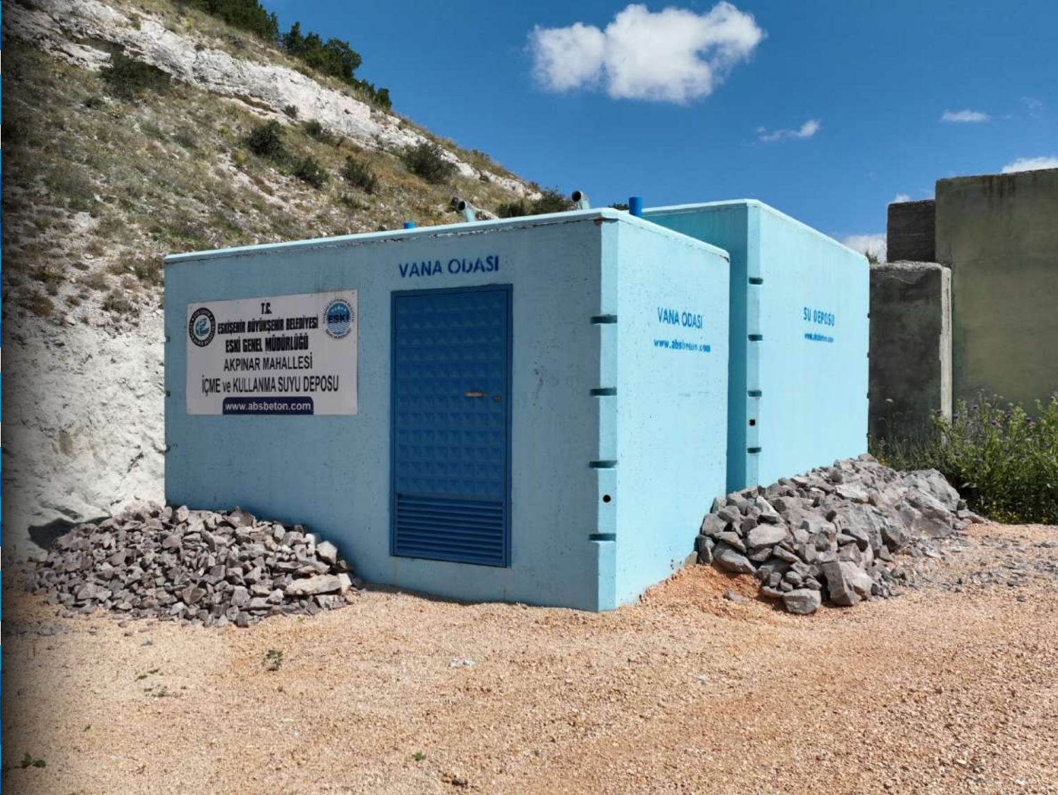
İçme ve Kullanma Suyu Deposu ve Vana Odası Montajı
