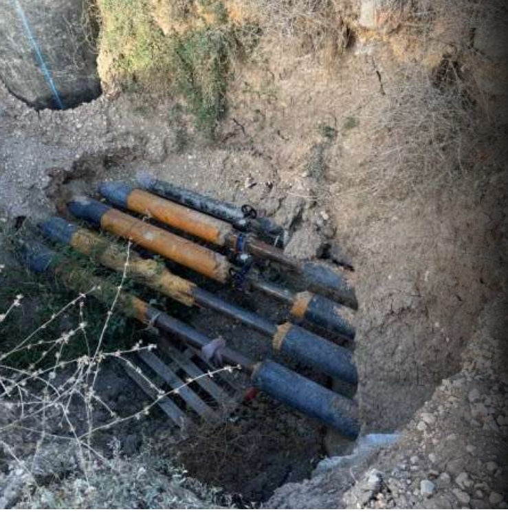
Sıcak Su Hatları ve Vana Montajı
