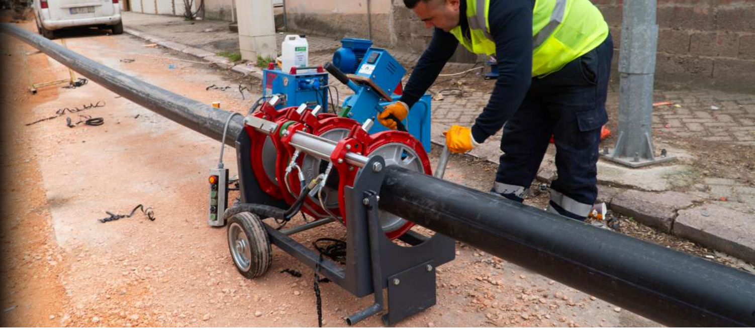
İçme ve Kullanma Suyu Şebeke Hattı Yapımı
