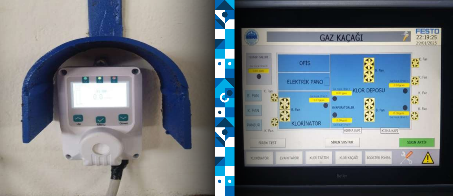
Klor Gazı Kaçak Alarm Sistemi
