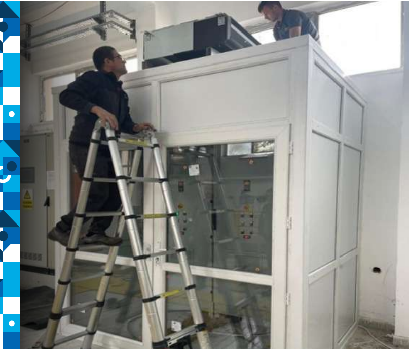
Hamsu Pompa İstasyonu Klima Montajı
