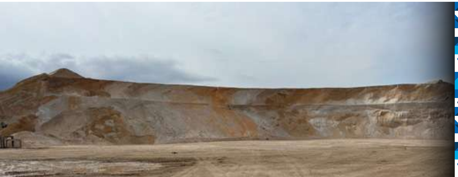
Mekanik Dolgu Malzeme Deposu
