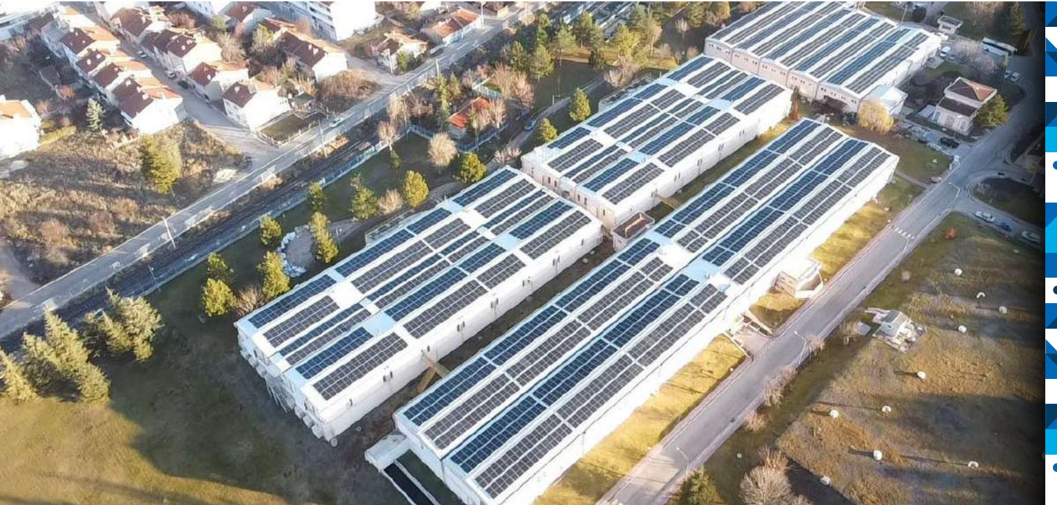
Çatı Tipi Güneş Enerjisine Dayalı Elektrik Üretim Tesisi
