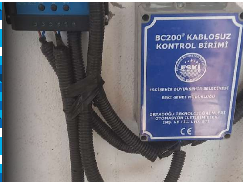
Haberleşme (RF) Sistemi Montajı
