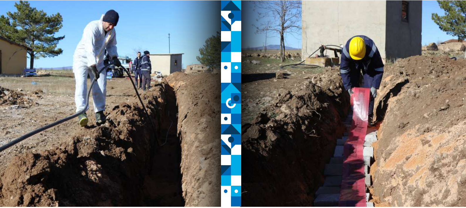
Hidrofor Sistemi Montajı Elektrik Nakil Hattı Yapım İşİ
