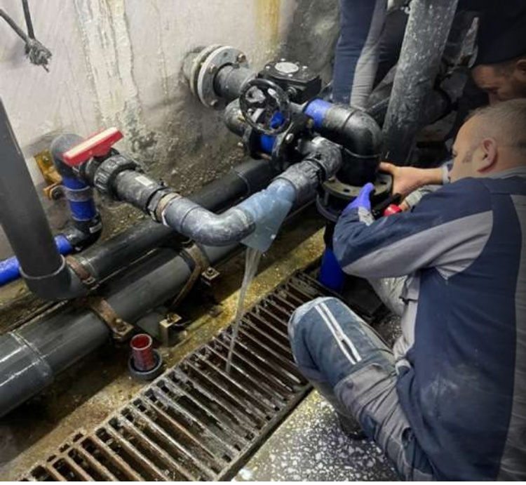
Alüminyum Sülfat Hattı Vana Değişimi
