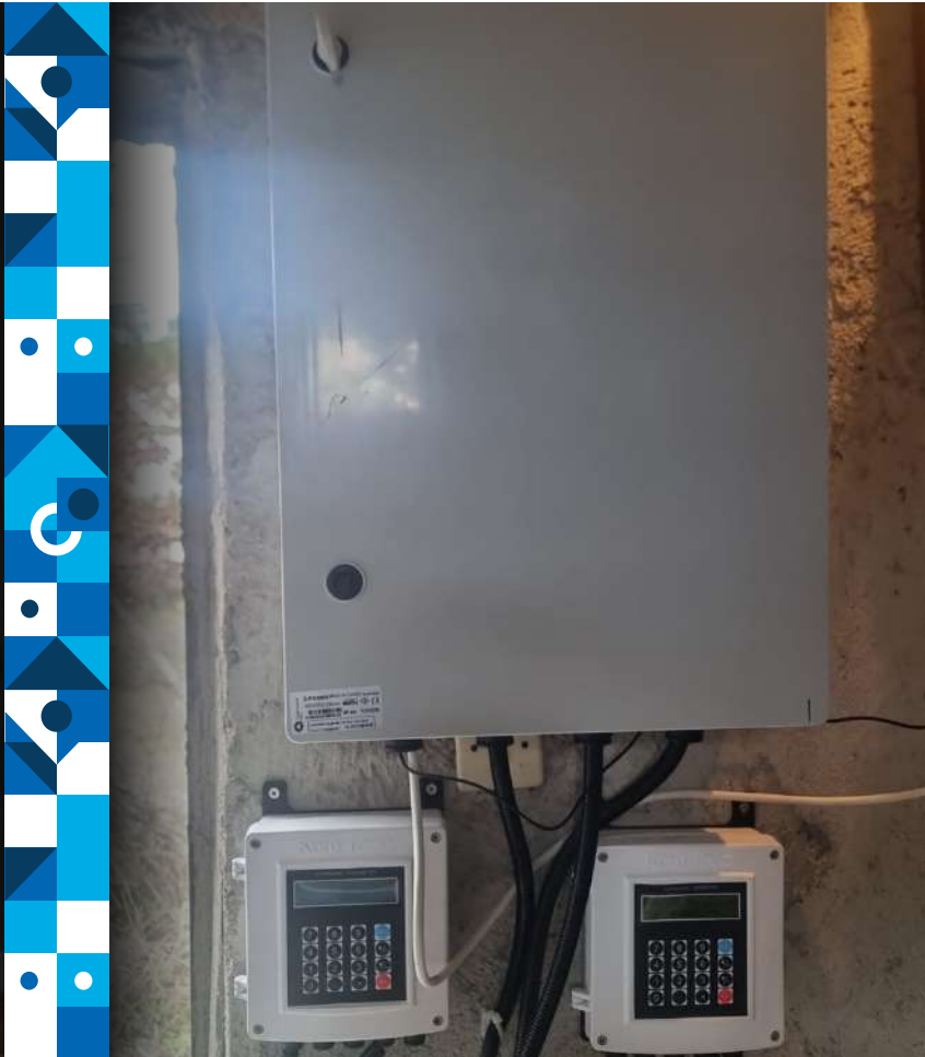
Erken Uyarı ve Otomasyon (SCADA) Sistemi Montajı
